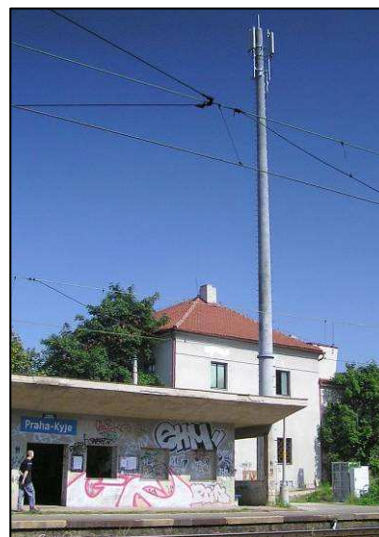
Obr. 2: Základová stanice GSM-R ve stanici Praha-Kyje
